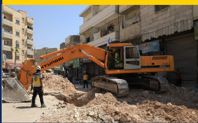
تأهيل شبكات المياه بطول 3,300 متر و شبكات الصرف الصحي بطول 5,050 متر في مدينة الباب.
