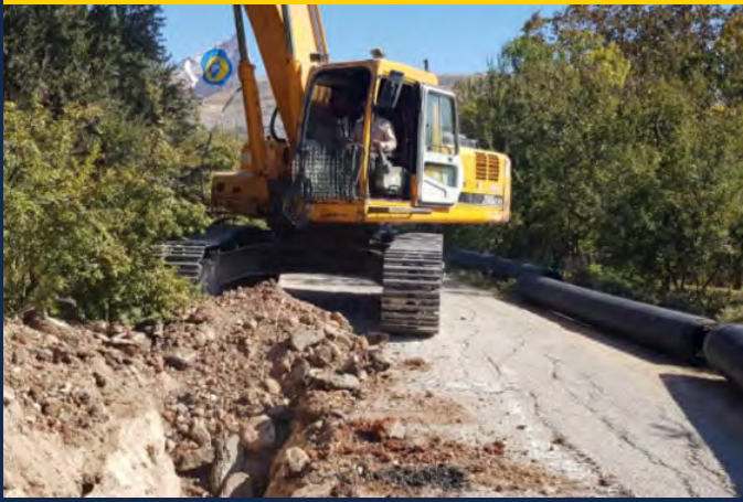
إعادة تأهيل 3000 متر من شبكات الصرف الصحي في مجتمع أبو طلحة.
